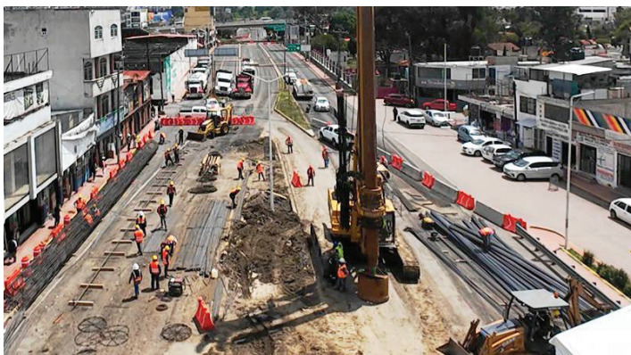
Imagen 5. Inicio de la construcción del Distribuidor Vial Chiautempan en agosto de 2025
